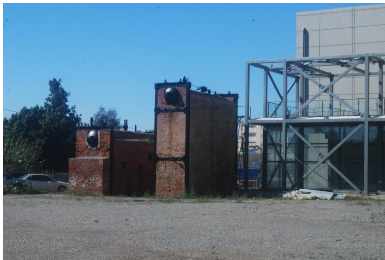
(Φωτ.2). Φούρνοι αποστακτηρίου Εργοστ. Λιναρδάκη
